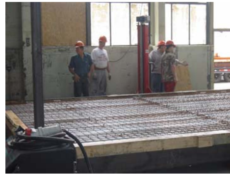
Figure 52 Floor ready for concrete pour
